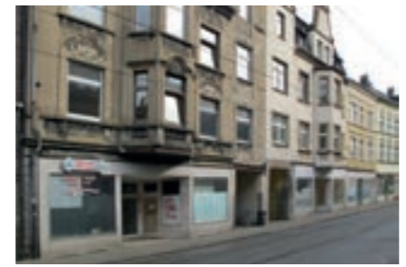
Schrottimmoblie in Gelsenkirchen vor der Sanierung © Christine Kämmerer
