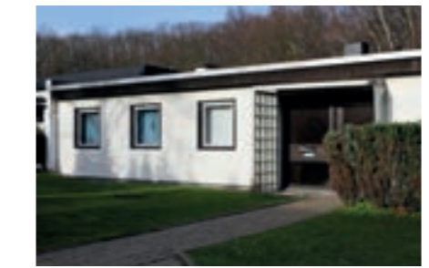
Sanierungsbedürftiges Einfamilienhaus in Herten © Cristóbal Márquez
